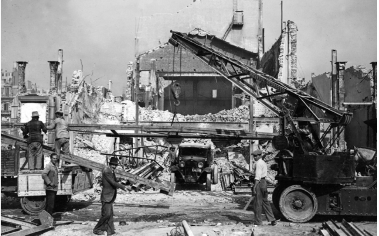
La fiebre de las demoliciones arrasa la ciudad. AGN. Dpto. Docs. Fotográficos. Inventario 4430.
