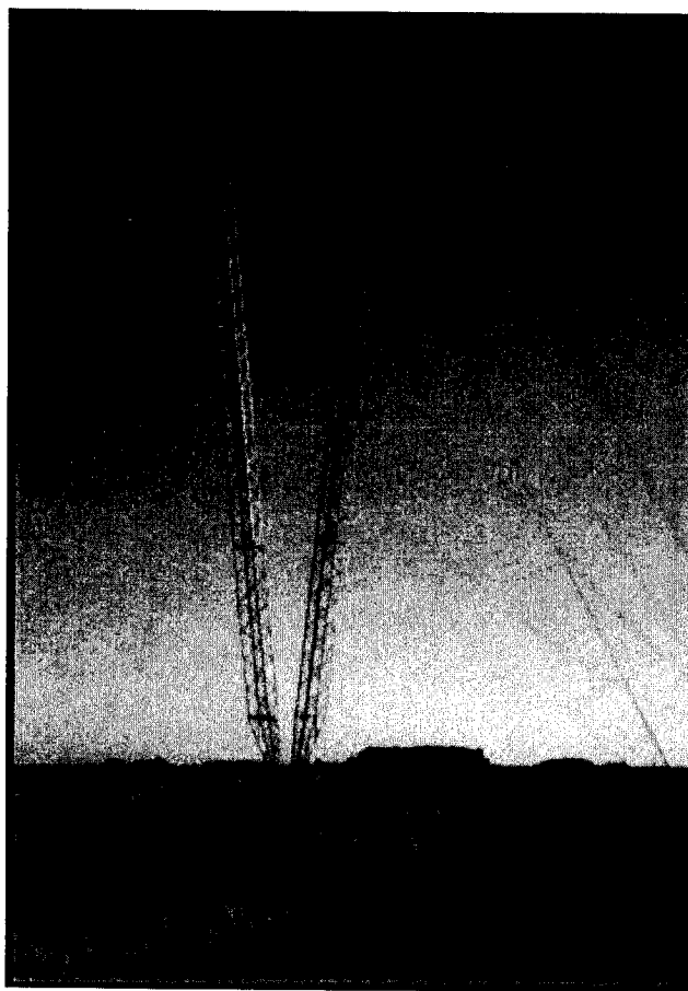
LINEA DE ALTA TENSION 500 Kv ALICURA - ABASTO
