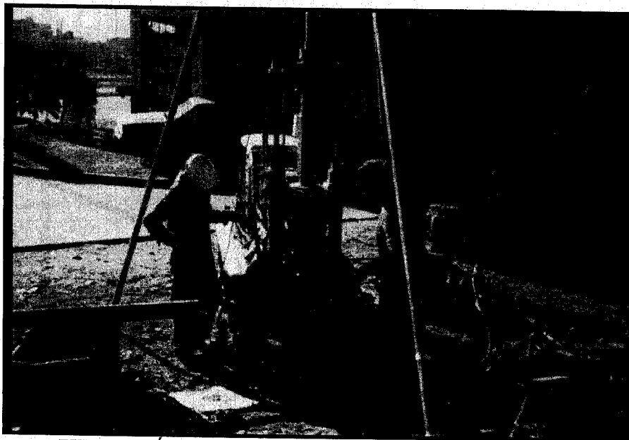
EXTRACCIÓN DE MUESTRAS DENISON DE 6" DE DIAMETRO
