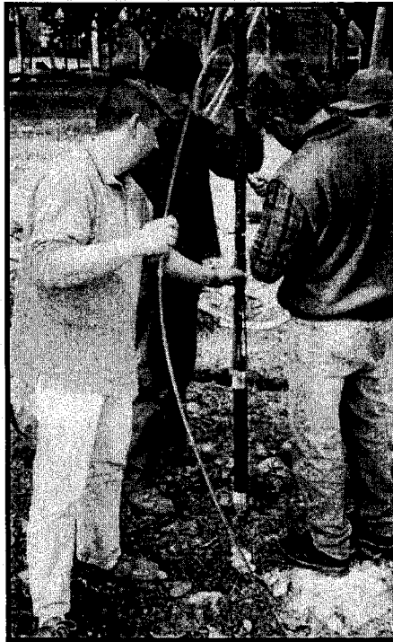
EJECUCIÓN DE ENSAYOS PRESIOMETRICOS
