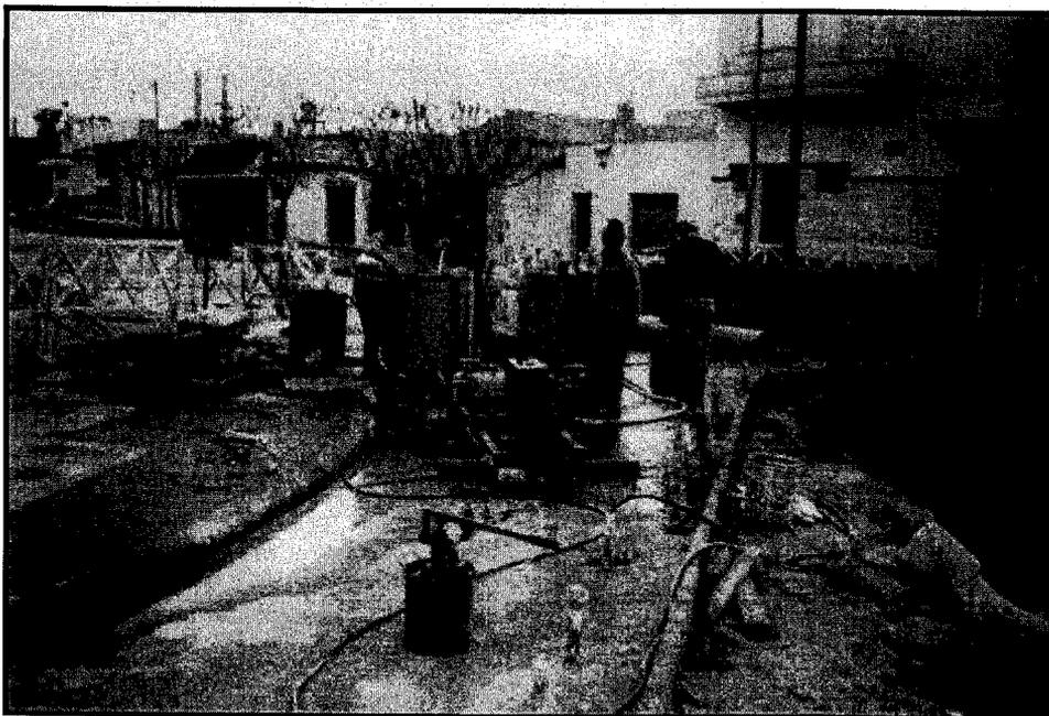
**EQUIPO DE INYECCIÓN DE LECHADAS DE CEMENTO**
