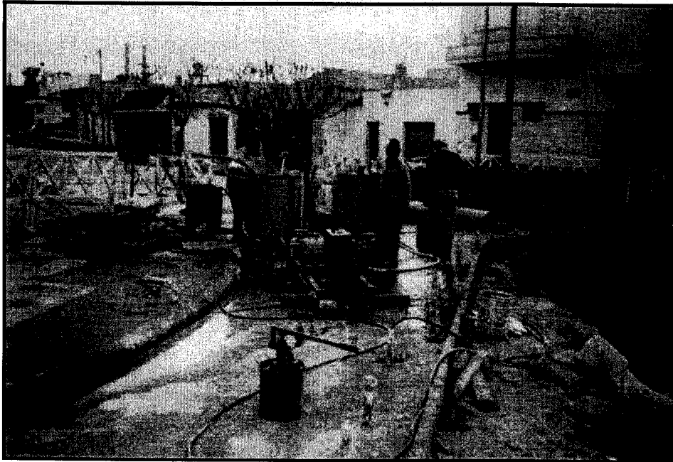
EQUIPO DE INYECCIÓN DE LECHADAS DE CEMENTO
