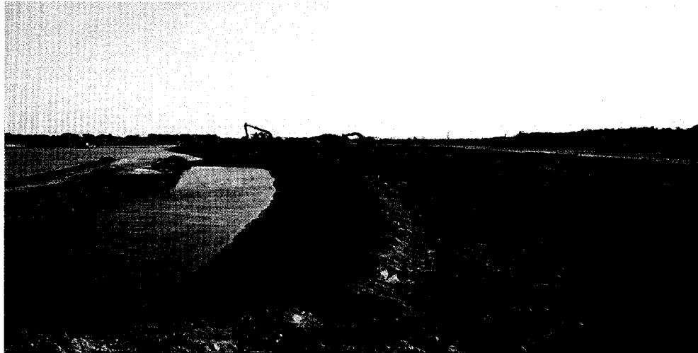
Excavación de taludes con retroexcavadora de brazo largo y dragado del cauce - Río Saldo - Tramo III - Sector 1.
