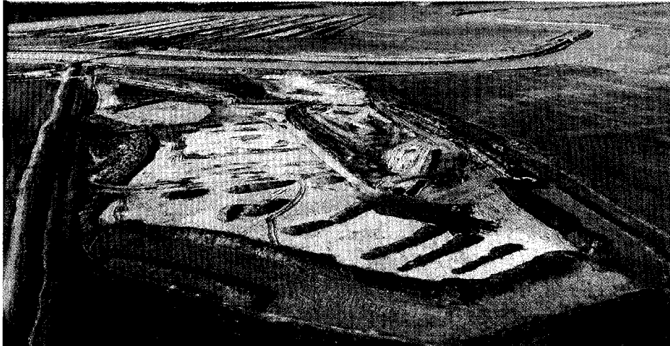
Recintos preparados para refulado y para suelo transportado en camiones – Rio Salado – Tramo III – Sector 1
