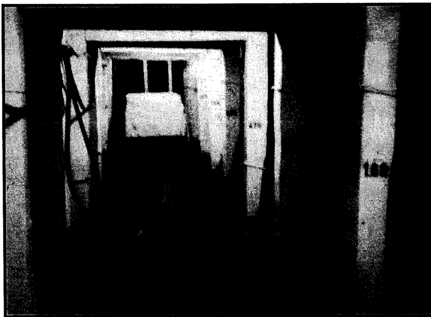
GALERIA DE INSPECCIÓN PARA DEFINIR LA FUNDACIÓN DE LA REPRESA DE PICHÍ PUCUN LEUFÚ
