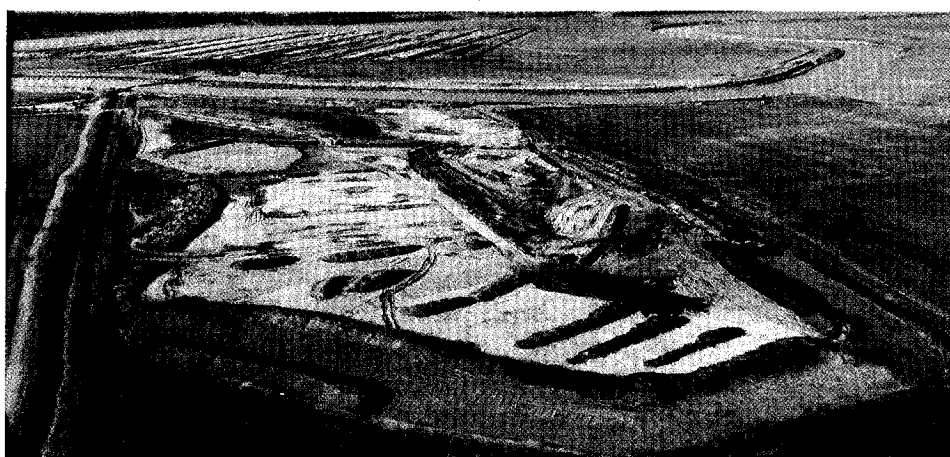
Recintos preparados para refulado y para suelo transportado en camiones – Rio Salado – Tramo III – Sector 1
