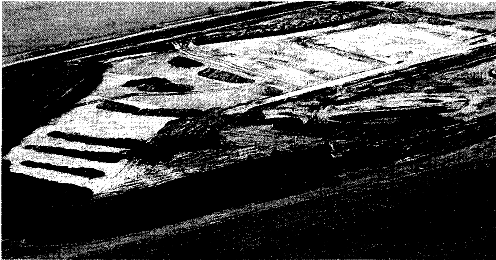
Trabajos de recubrimiento final con suelo orgánico – Rio Salado – Tramo III - Sector 1
