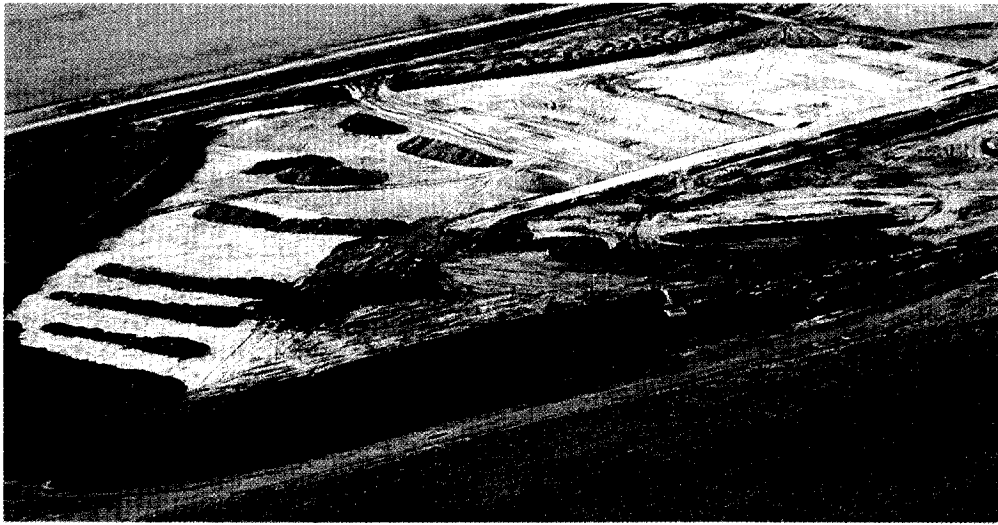
Trabajos de recubrimiento final con suelo orgánico – Rio Salado – Tramo III - Sector 1
