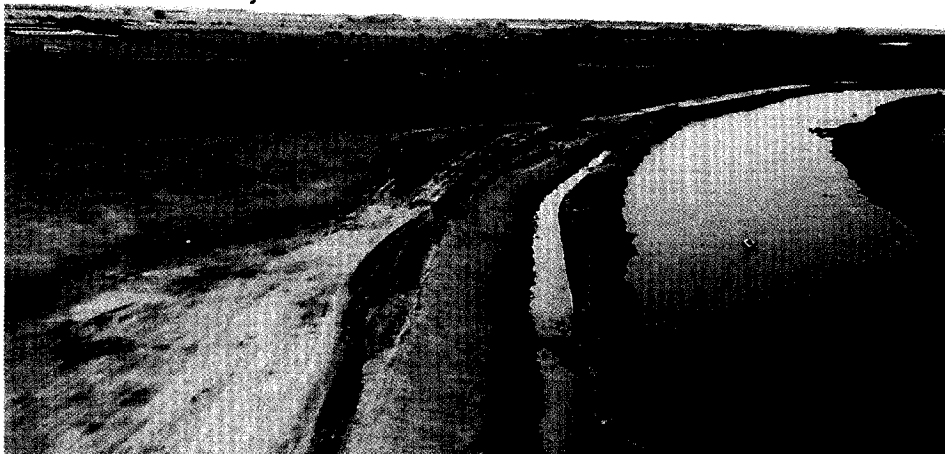
Excavación y perfilado de taludes previo al paso de la draga – Rio Salado - Tramo III – Sector 1
