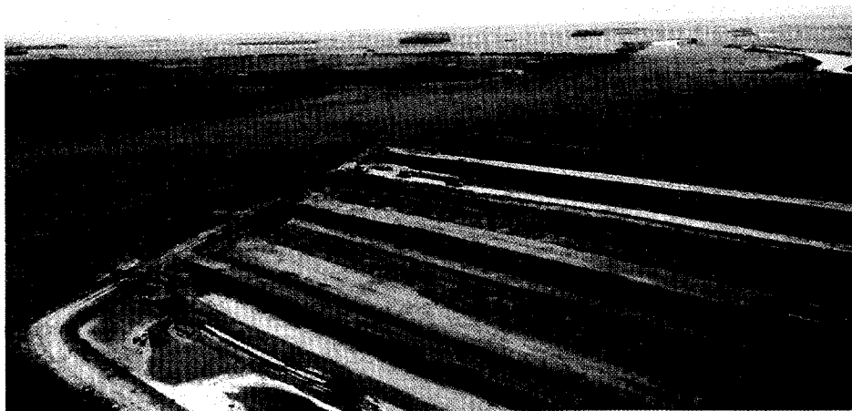
Recinto para deposito del material proveniente del dragado y de la excavación terrestre – Rio Salado Tramo III – Sector 1
