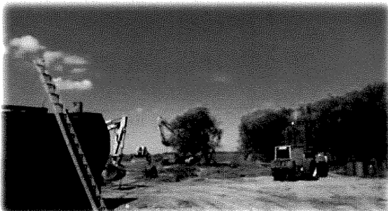
Armado de obrador
