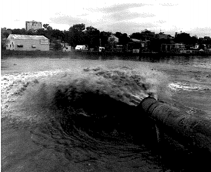
Descarga en recinto
