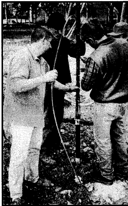
EJECUCIÓN DE ENSAYOS PRESIOMETRICOS
