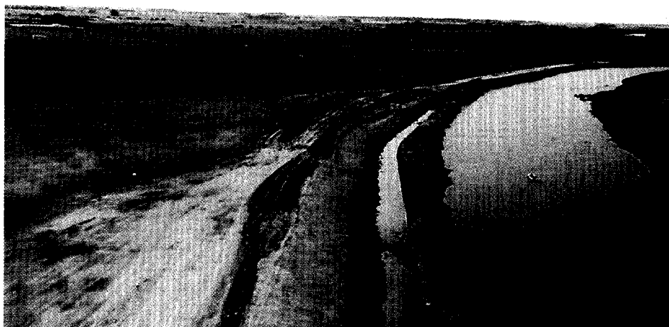
Excavación y perfilado de taludes previo al paso de la draga – Rio Salado - Tramo III – Sector 1
