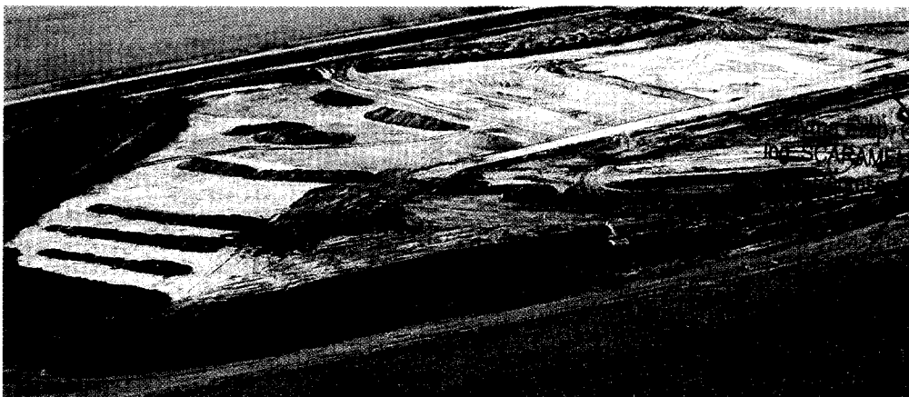
Trabajos de recubrimiento final con suelo orgánico - Río Salado - Tramo III - Sector 1
