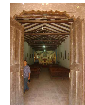
Restauración carpintería y pisos interiores
