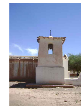
Consolidación estructural de torre de campanario
