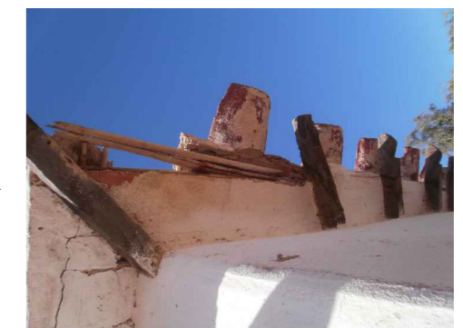
Reparación y restauración de techo campanario
