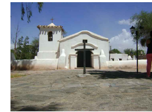
Escasa iluminación exterior.
