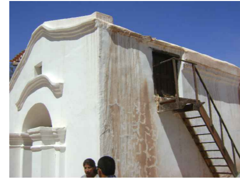
Reparación, refuerzo de escalera coro
