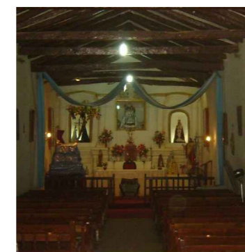
Reparación y refuerzo de altar y mampostera de fondo.
