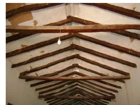
Baja iluminación interior
