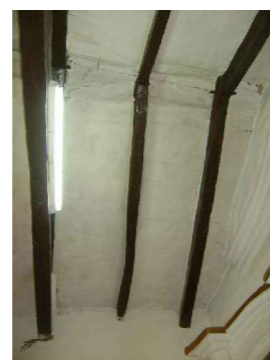
Consolidación de estructuras de madera y ajustes de cañizo. Reconstrucción de cieloraso, previo tratamiento de cubierta existente
