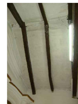
Consolidación de estructuras de madera y ajustes de cañizo. Reconstrucción de cielorraso, previo tratamiento de cubierta existente
