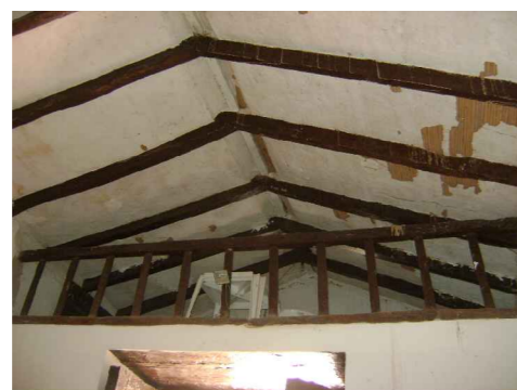
Consolidación de estructuras de madera y ajustes de cañizo. Reconstrucción de cieloraso, previo tratamiento de cubierta existente
