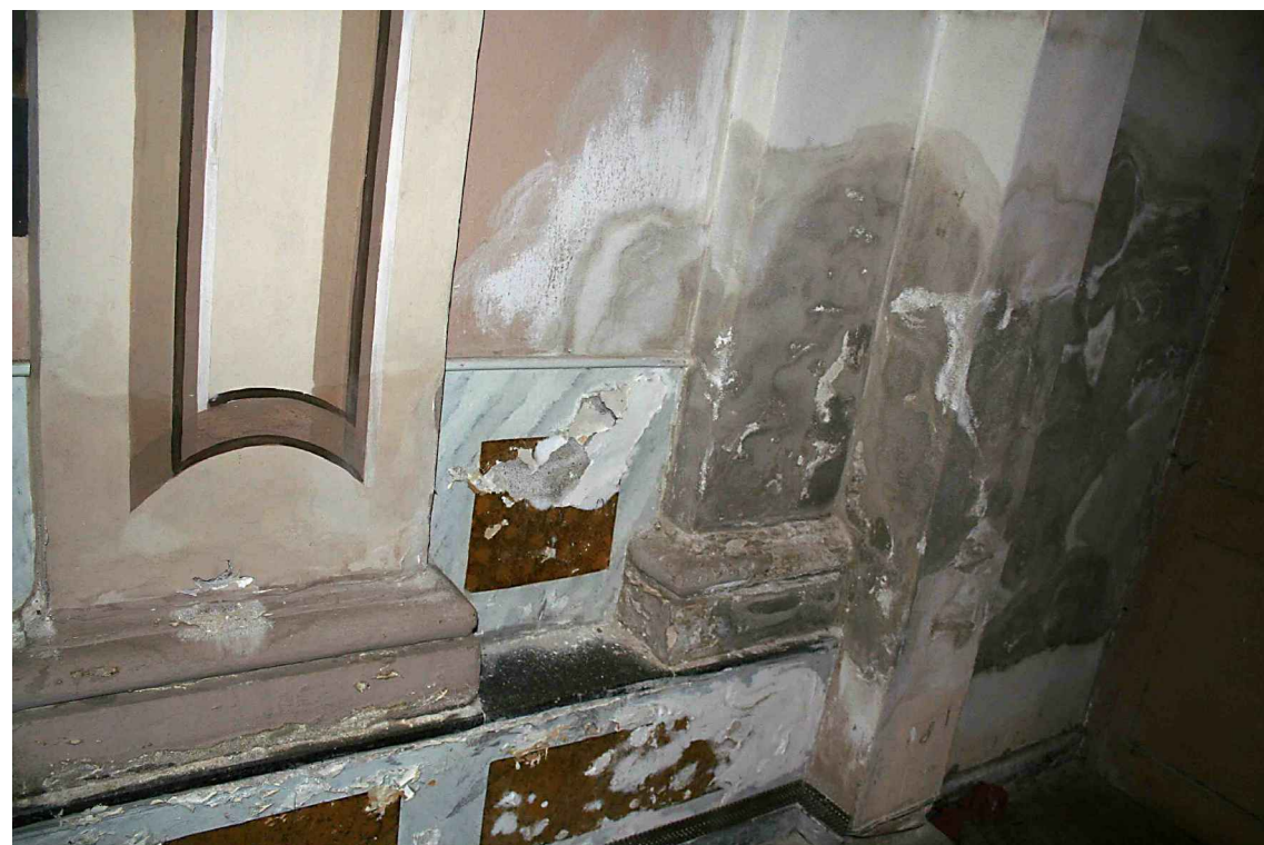
DETALLE DE FALSO MARMOL A REHACER EN BASAMENTO
