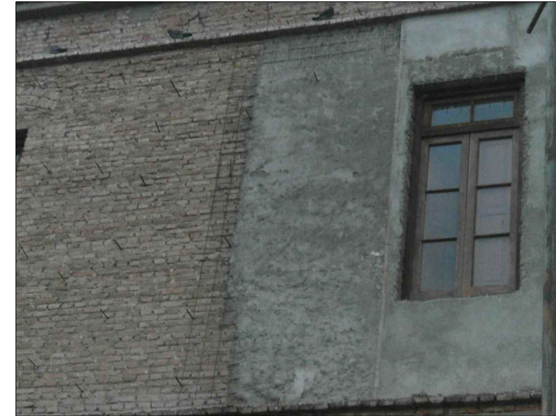
FOTOS CONSOLIDACION DEL MURO
