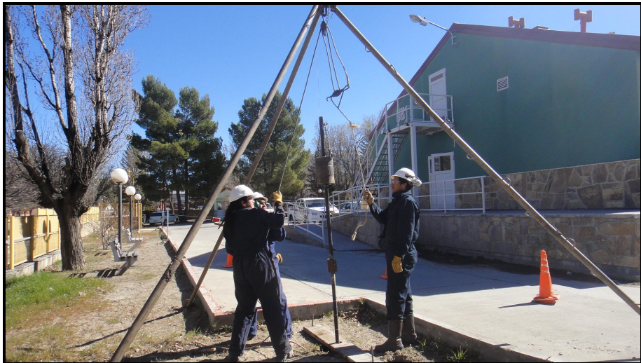
Ensayo SPT en Sondeo 2
