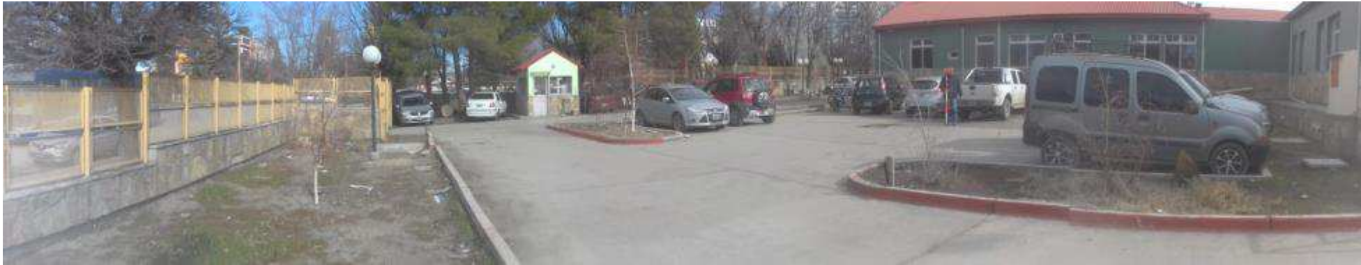
Foto N° 3: Sitio de construcción de Planta Baja, acceso principal y sector de consultorios.
