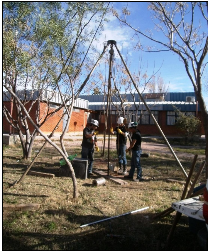
Maniobra de extracción de las barras del sondeo 1
