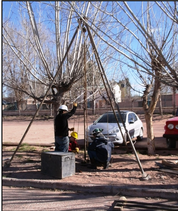
Maniobra de extracción de las barras del sondeo 2
