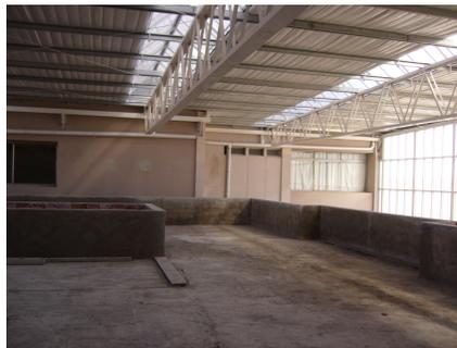
Comprendió la ejecución de una cubierta metálica de 600 m2, con vigas principales y secundarias metálicas, apoyos metálicos abrochados a estructura de hormigón existente, ejecución de losa premoldeada de 230 m2, que reemplaza el viejo techo de chapa de la torre central.
