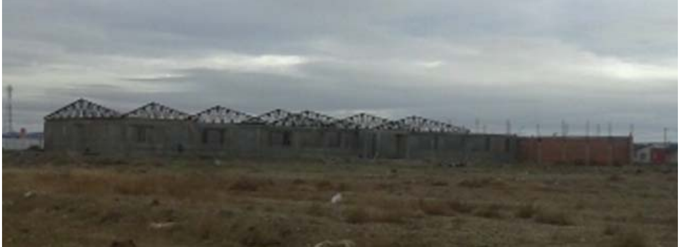
Vista general del edificio.
