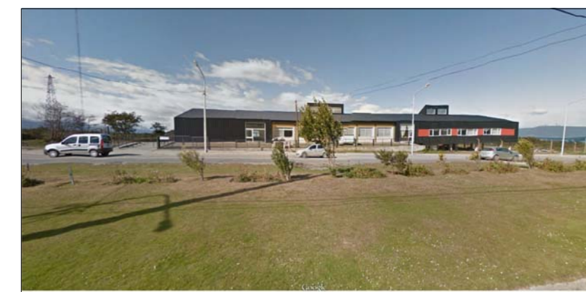
FOTO 3 - VISTA DESDE AVENIDA YRIGOYEN
