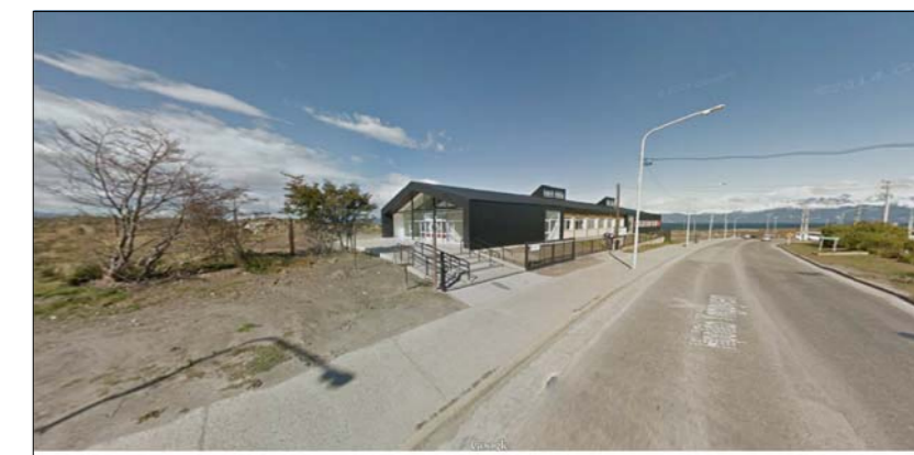
FOTO 2 - ACCESO NORTE AVENIDA YRIGOYEN
