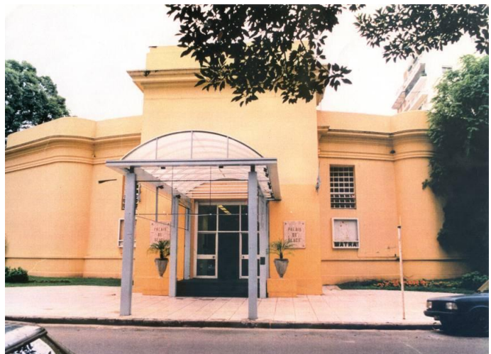
Foto n°18: Fachada Posadas – Año 1996
