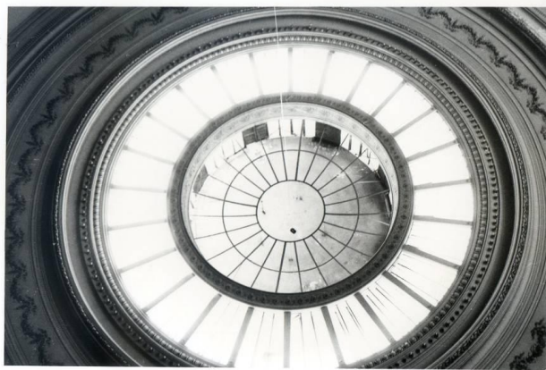
Foto n° 15: En proceso de intervención – año 1974
