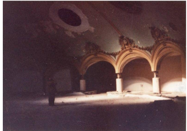
Foto n° 16: Incorporación del entrepiso
