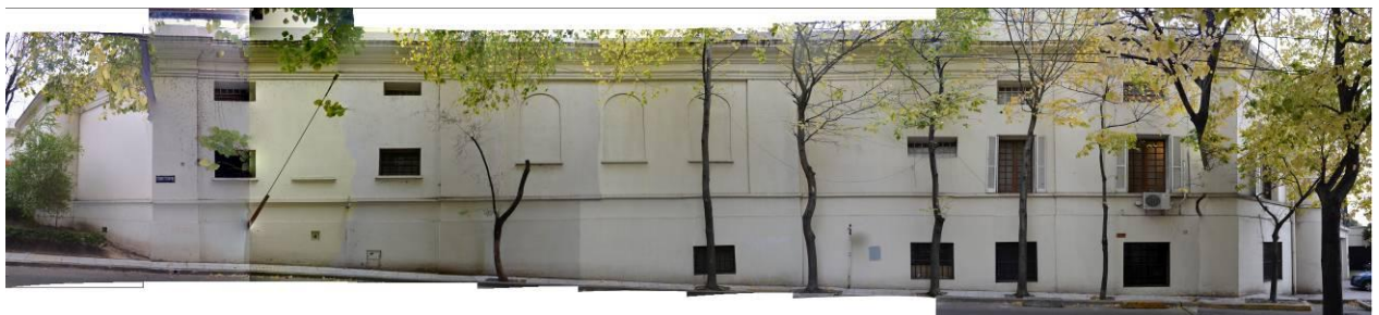
Foto n° 26: Fachada Eduardo Schiafino – Año 2015
