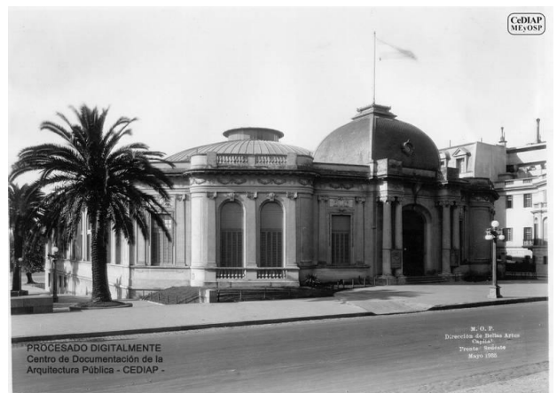
Foto n° 2: Fachada Posadas – Año 1935
