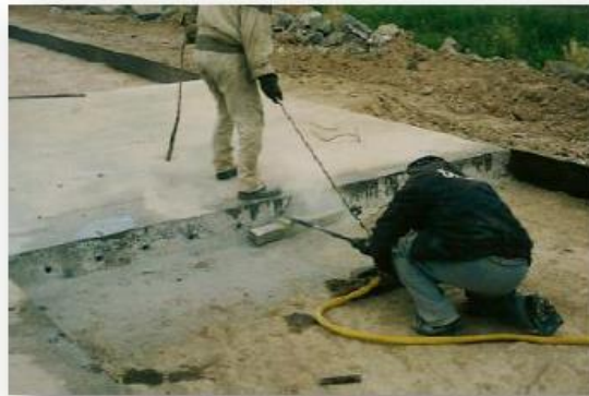
d) Restitución de las condiciones de transferencia de carga
