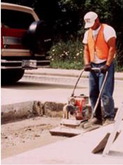
d) Restitución de las condiciones de transferencia de carga
