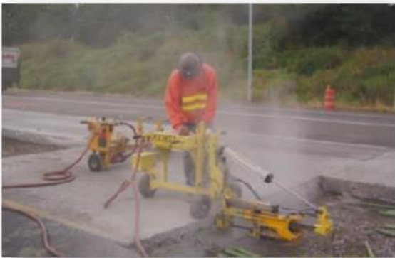
d) Restitución de las condiciones de transferencia de carga
