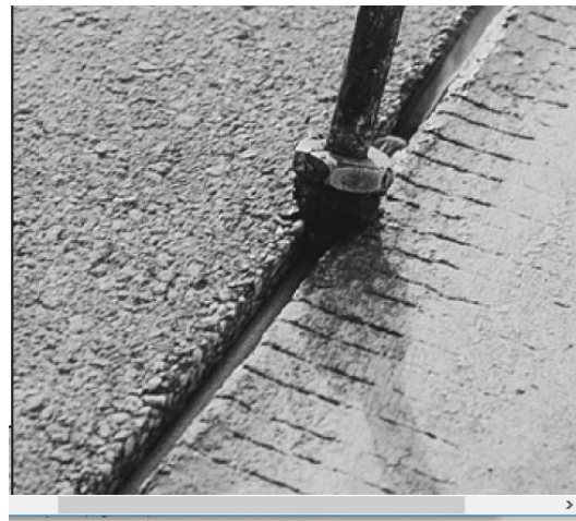
Instalación del Sellador de Juntas de Silicona Autonivelante
