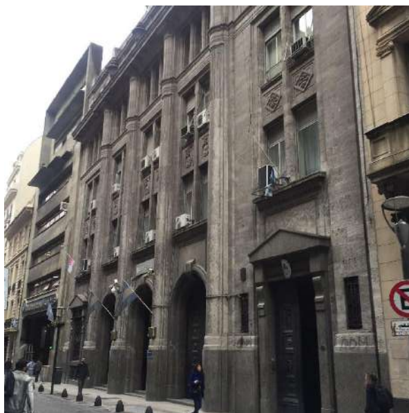
Edificio Sede del Ministerio del Interior, Obras Públicas y Vivienda, EX - BANADE. "Restauración y Puesta en Valor Fachadas" PLIEGO DE ESPECIFICACIONES TÉCNICAS
