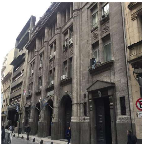
Edificio Sede del Ministerio del Interior, Obras Públicas y Vivienda, EX - BANADE. "Restauración y Puesta en Valor Fachadas" PLIEGO DE ESPECIFICACIONES TÉCNICAS
