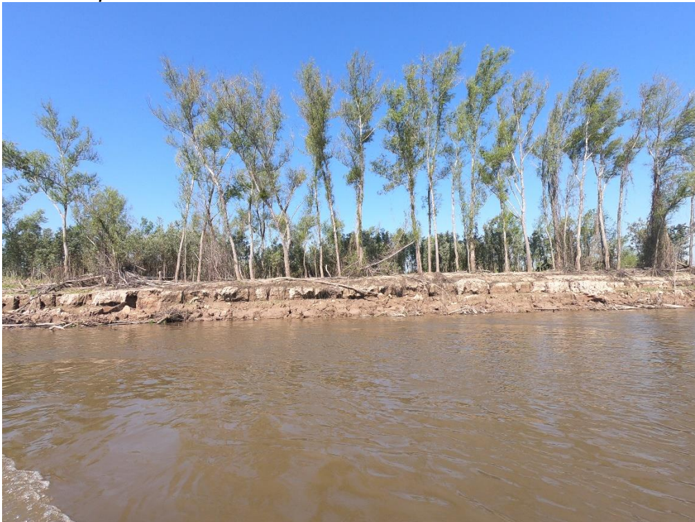
Figura 10: Margen izquierda, agua abajo. Esta zona es más baja que las anteriores, aunque es notoria la presencia de árboles caídos y el corte del talud que muestran un efecto erosivo durante las crecidas.
