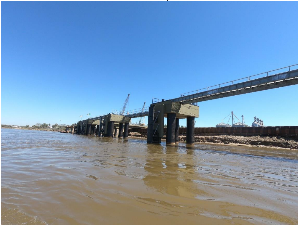
Figura 9: Margen izquierda, muelle. La costa fue modificada con la instalación del tablestacado posterior.
