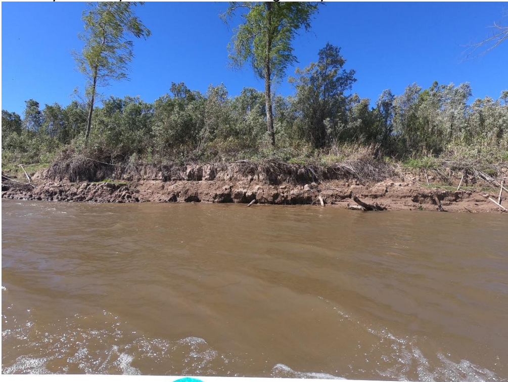
Figura 8: Margen derecha, aguas arriba, frente al muelle. Se observa el corte que el río produce sobre la margen exponiendo las raíces.
