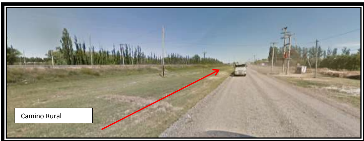
Fotos 34 a 36: Calles Los Naranjos, Las Jarillas y Camino Rural entre V. Regina y G.E. Godoy.
