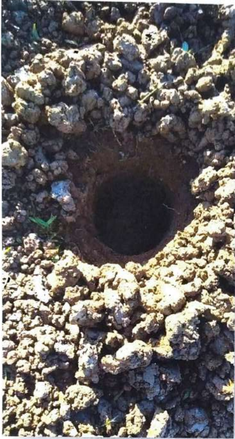
Imagen N°2: Perforación Sondeo S1
