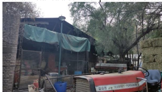
Estructura Metálica a demoler para ubicar Cisternas SCI
