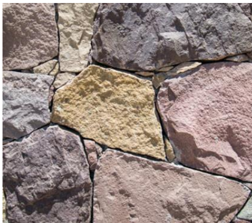
Ejemplo de muros de pirca.
