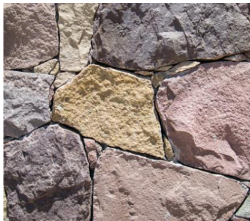
Ejemplo de muros de pirca.
