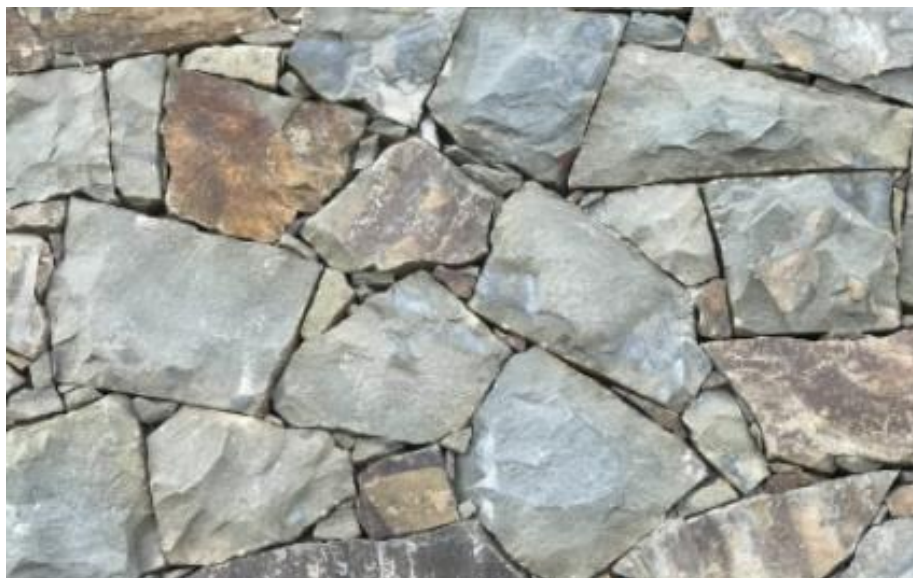
Ejemplo de muros de pirca tipo verde musgo.
