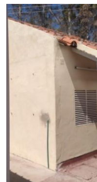
Ilustración 60. Sala de tableros
