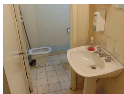
Ilustración 51. Baños CENTRO DE FRONTERA
