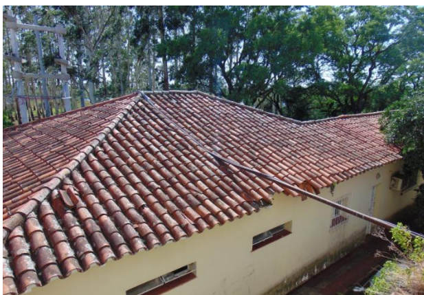
Ilustración 58. Transformador y acometida (pasa por la cubierta de los sanitarios públicos)
