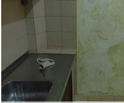
Ilustración 192. Cocina CENTRO DE FRONTERA
