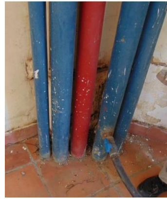
Ilustración 20. Cañería contra incendio tanque de reserva (rojo)
