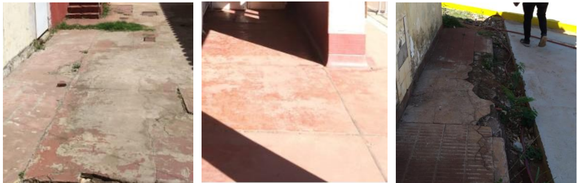
Ilustración 42. Imágenes de solados exteriores actuales
