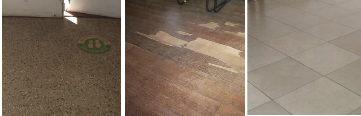
Ilustración 141. Solados interiores actuales.
