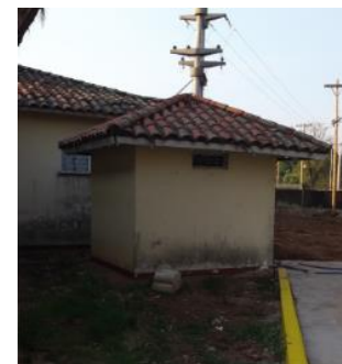
Ilustración 227. Gabinete - tablero iluminación puente
