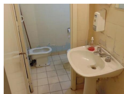
Ilustración 51. Baños CENTRO DE FRONTERA
