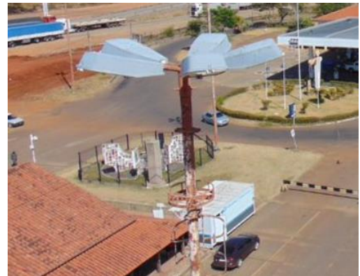
Ilustración 71. Torres actuales de iluminación.
