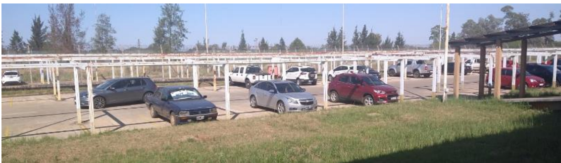
Ilustración 90. Problemas de drenaje de aire acondicionado, ascensores dañados, cerco perimetral, estacionamientos sin cubiertas.
