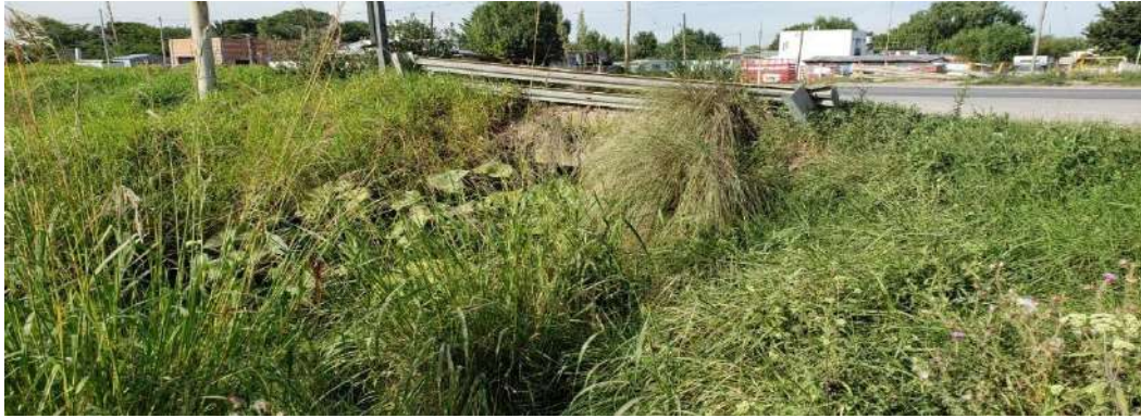
Alcantarilla Pr:16+800 aguas arriba
