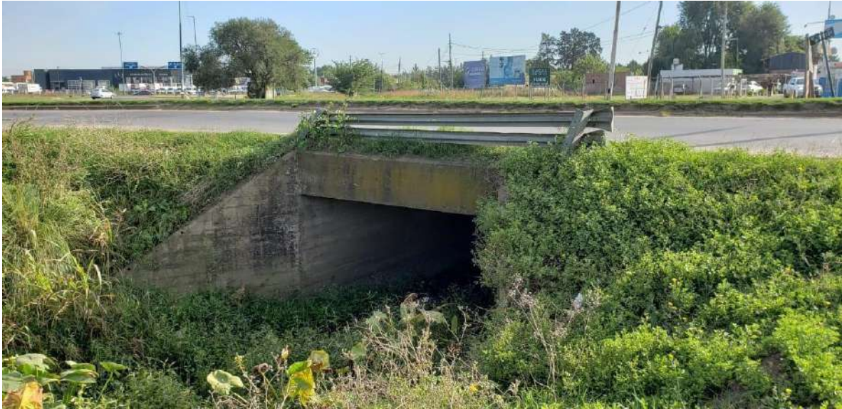
Alcantarilla Pr:16+040 aguas arriba
