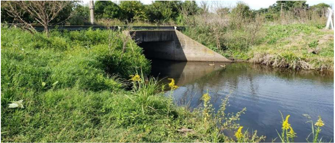
Alcantarilla Av. 66 - Sur
