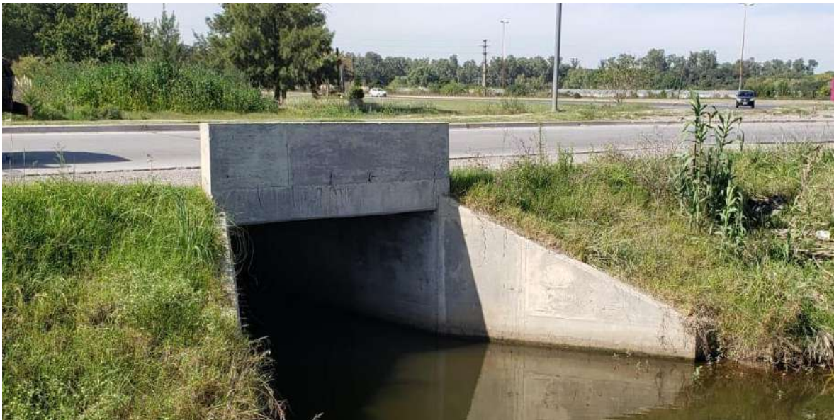
Alcantarilla Av. 66 - Norte
