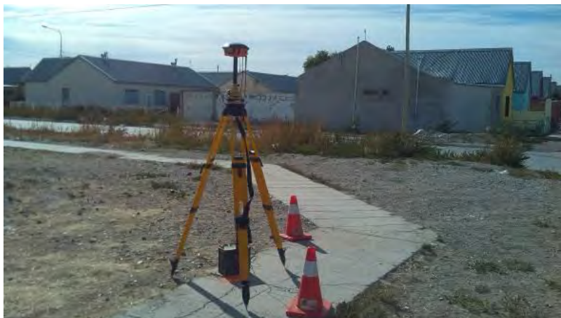
Imagen 43 Equipos de Topografía durante el levantamiento de la plaza de la manzana n°242
