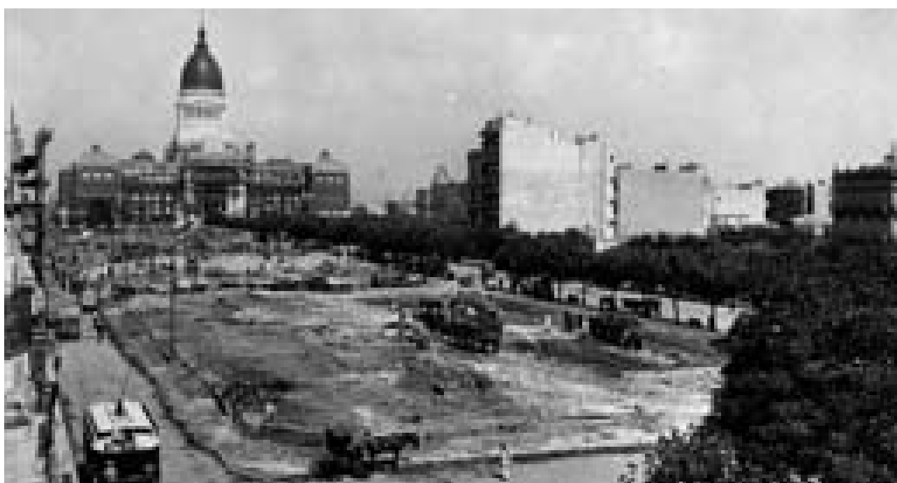
Imágenes del Congreso de la Nación en obras. Archivo General de la Nación.
